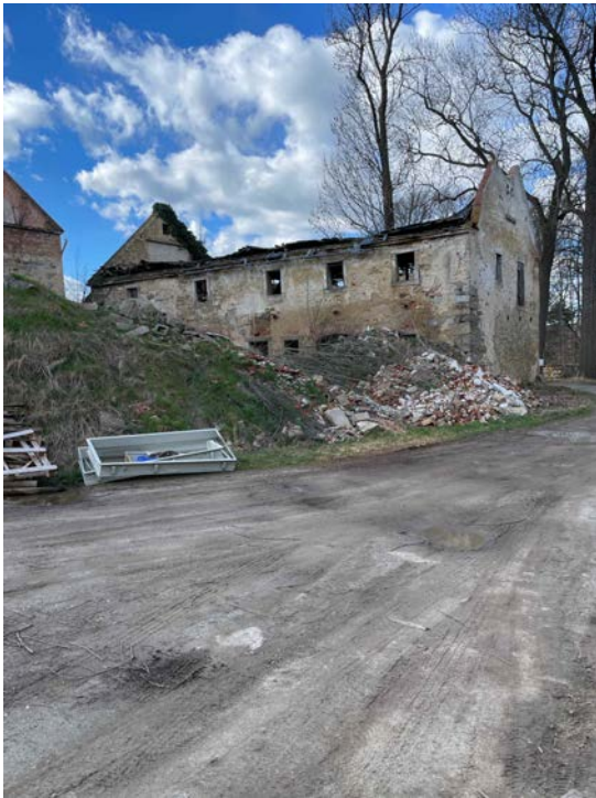
Abbruchgebäude mit Bauschutthaufwerk mit befestigtem Weg.
