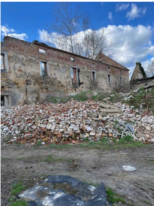
Abbruchgebäude mit Bauschutthaufwerk
