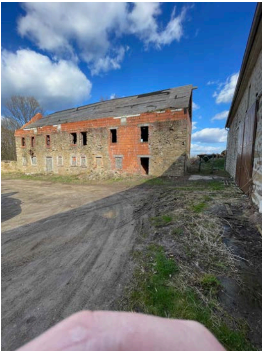
Abbruchgebäude mit befestigtem Weg
